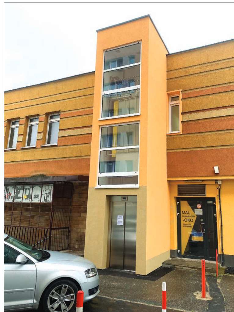
Dobudowa szymbu murowanego częściowo przeszklonego.
