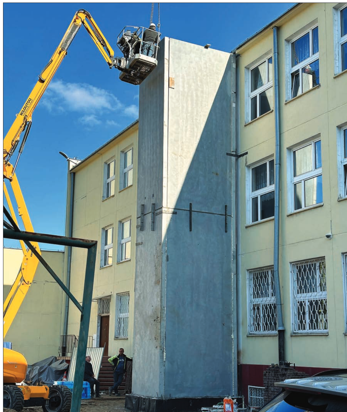
Montaż prefabrykowanego szybu.
